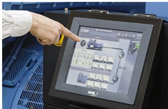
Le nouveau coffret de contrôle commande APM802 est dédié à la conduite et la surveillance des centrales d'énergie pour les marchés hôpitaux, datacenters, banques, secteur pétrolier et gazier, industries, IPP, location et mines.
